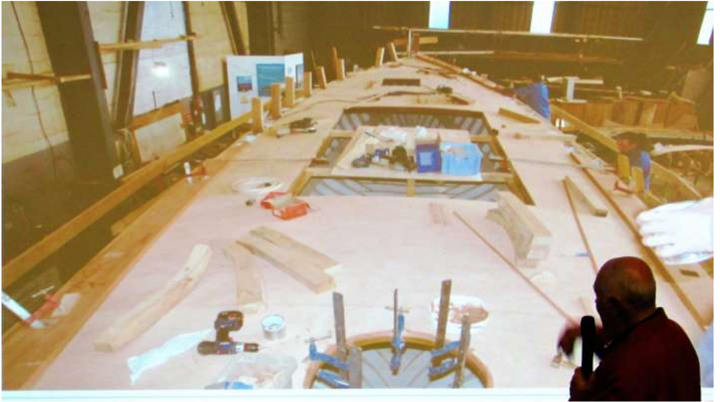
Placage du PONT qui sera ensuite latté, après la construction du ROUF.
