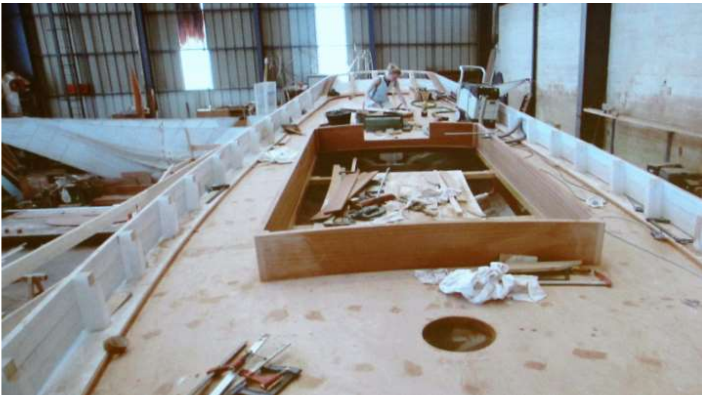
Construction du ROUF
